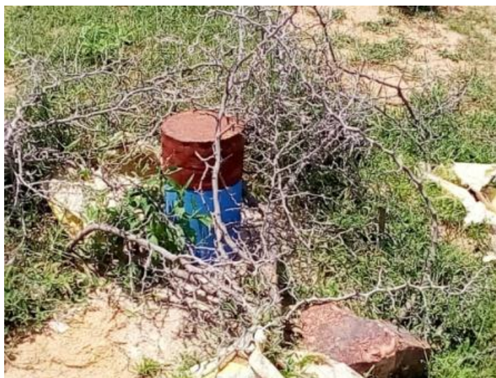
Vue sur le forage non équipé - Site de Bandé (Magaria)
