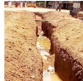
Vue des fouilles de pose des tuyauteries
