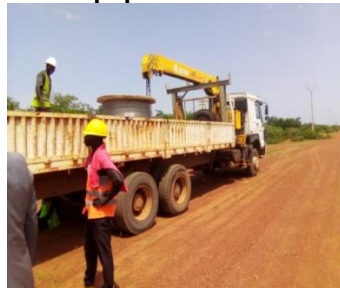
Équipe de pose du câble
