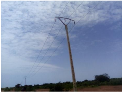
Pose des appareillages
