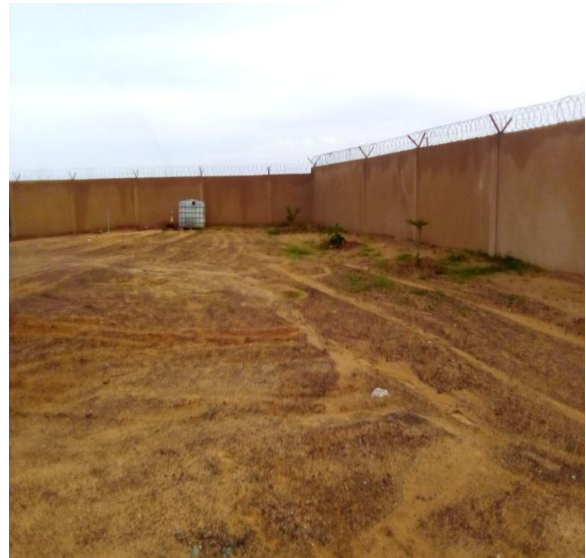
Vue du mur de clôture
