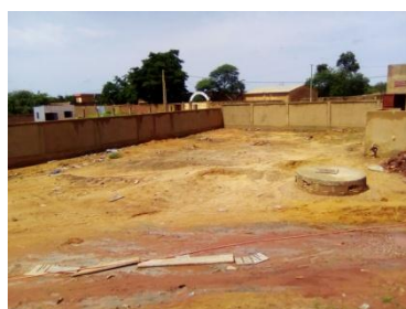
Mur de clôture
