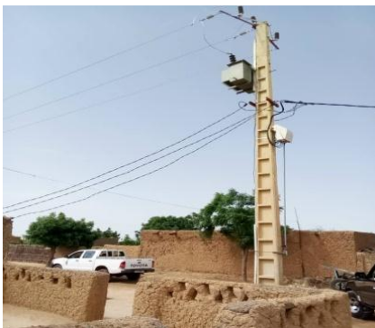
Vue de la pose du câble
