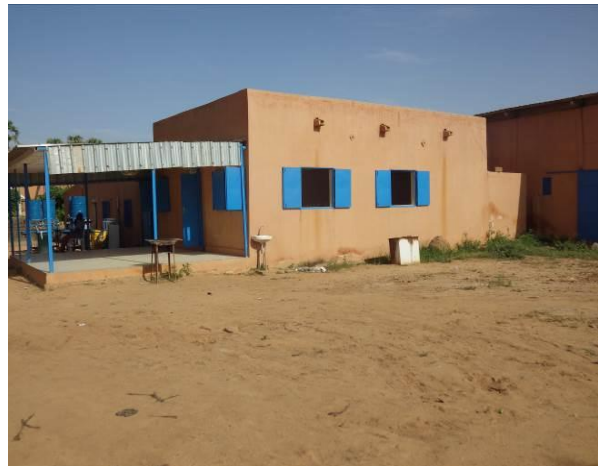
Réhabilitation Hôpital de Lamordé - Peinture
