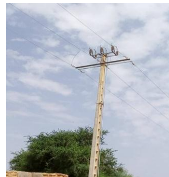
Pose des appareillages
