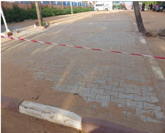
Pavage Hôpital de Lamordé
