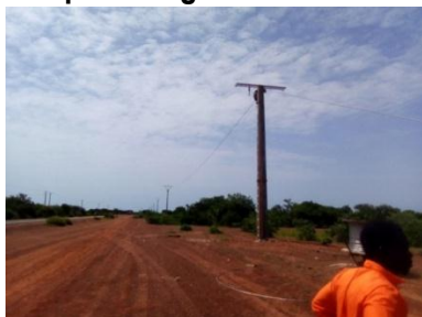
Vue de la pose du câble
