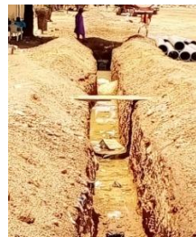
Vue des fouilles de pose des tuyauteries
