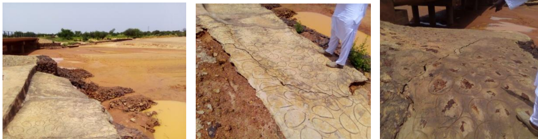
Vue sur les travaux de réparations des ouvrages
