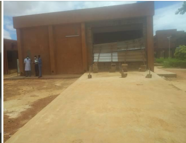
Rampe d'accès pour l'Appareil d'IRM
