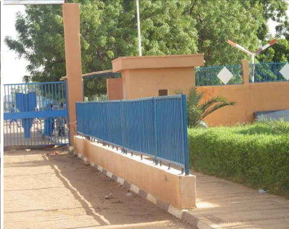
Réhabilitation Hôpital de Lamordé
