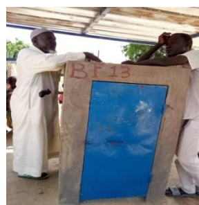
Problème de raccordement des menuiseries
