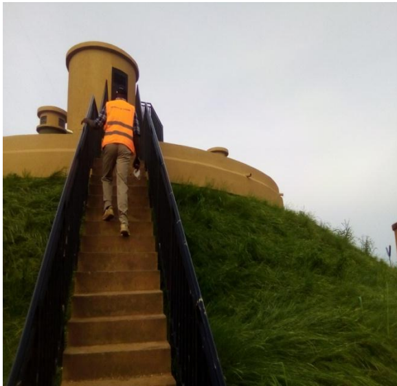
Vue générale du réservoir 1500 m3
