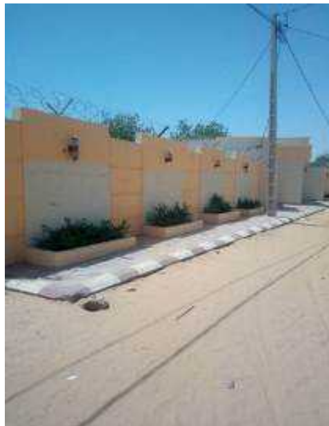
Mur de clôture
