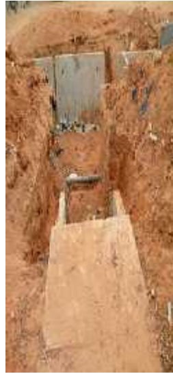
Coffrages mal fait dallâtes du collecteur
