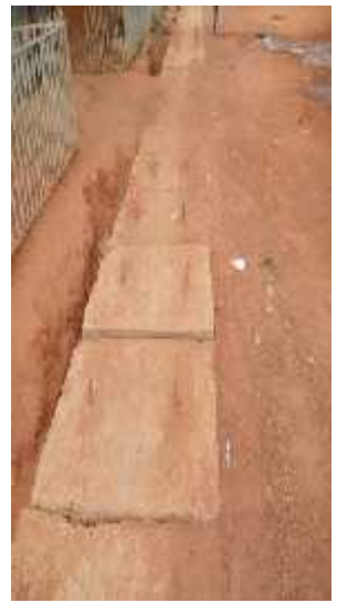
Coffrages mal fait dallâtes du collecteur
