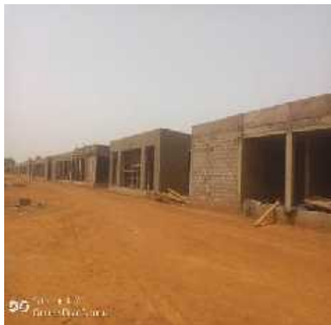
Boutique exterieur en cours d'execution
