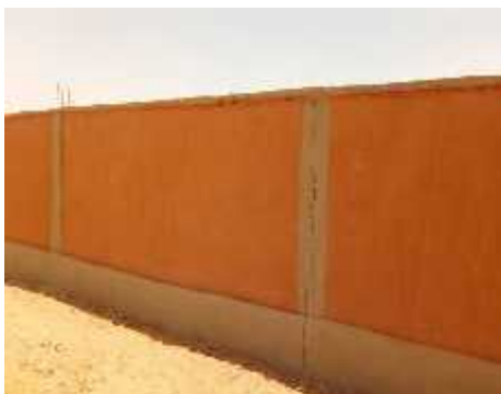
Vue Générale de mur de clôture
