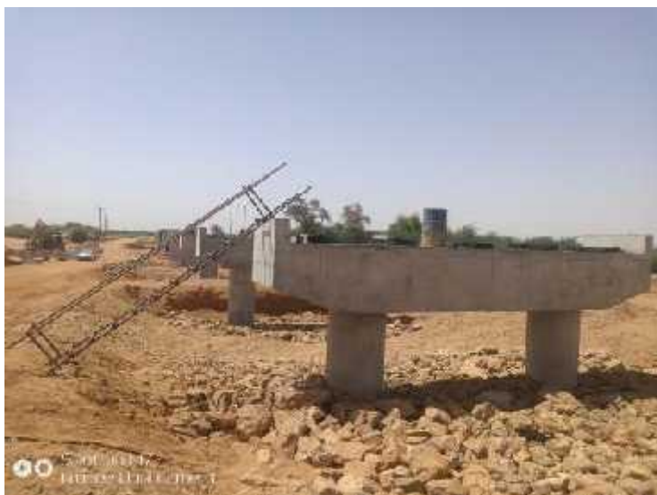
Vue General des travaux
