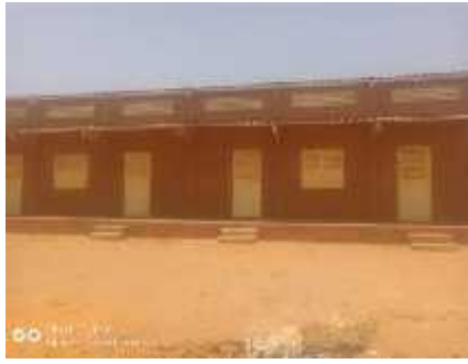
Blocs des classes terminés
