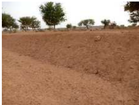
Digue de protection
