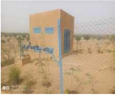
Forage et abri groupe
