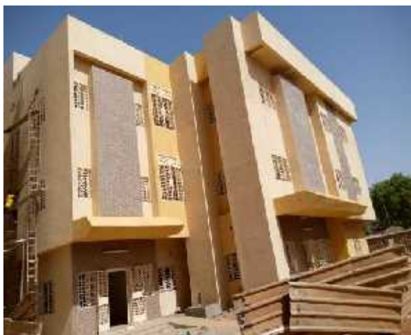
VUE GENERAL DES TRAVAUX
