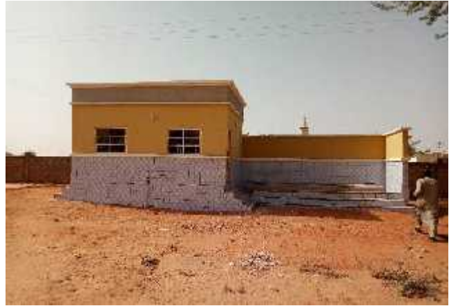
Vue de l'extérieur toilette
