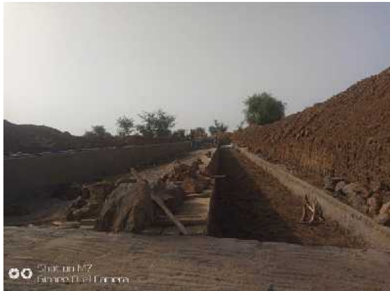
Vue d'ensemble du Seuil
