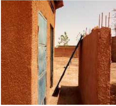
Vue générale des latrines
