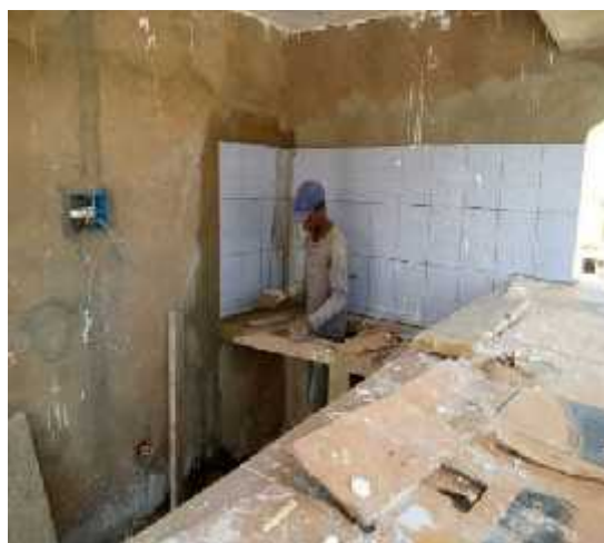
TRAVAUX EN COURS
