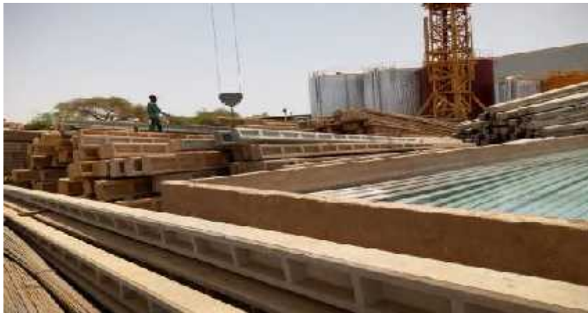
Vues des poteaux fabriques
