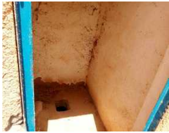
vue intérieur des latrines
